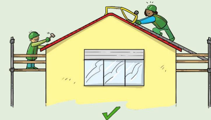
Mjere zaštite i zdravlja na radu koje će sprječiti da zaposleni padnu mogu uključivati gornju zaštitnu ogradu na visini od 1 metar i srednju zaštitnu rampu na visini od oko pola metra iznad radne platforme. Potrebna je i poprečna greda za gaženje, koja će sprječiti da predmeti padnu na ljudе koji rade ispod.
